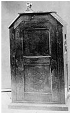
Kinetoskopen , apparatet til individuelle filmoplevelser. Tilskueren skulle kigge gennem linsen i toppen for at se film. Den første Kinetoskopbutik, ejet af brødrene George og Andrew Holland, åbnede i New York den 14. april 1894. Fem maskiner var placeret på række, og tilskueren kunne se filmene i hver enkelt af dem for en sum på 25 cents.
